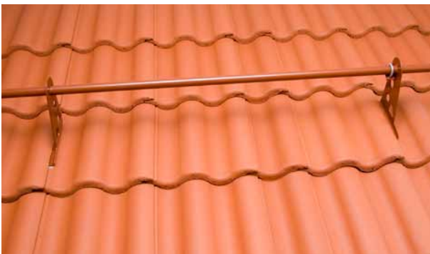
Bild 4: Nock- och takfotsräcke montering med fäste
